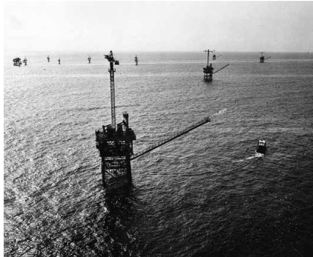
Plateformes du champ offshore d'Émeraude Marine Elf-Congo démarre la production à partir de 1971.
