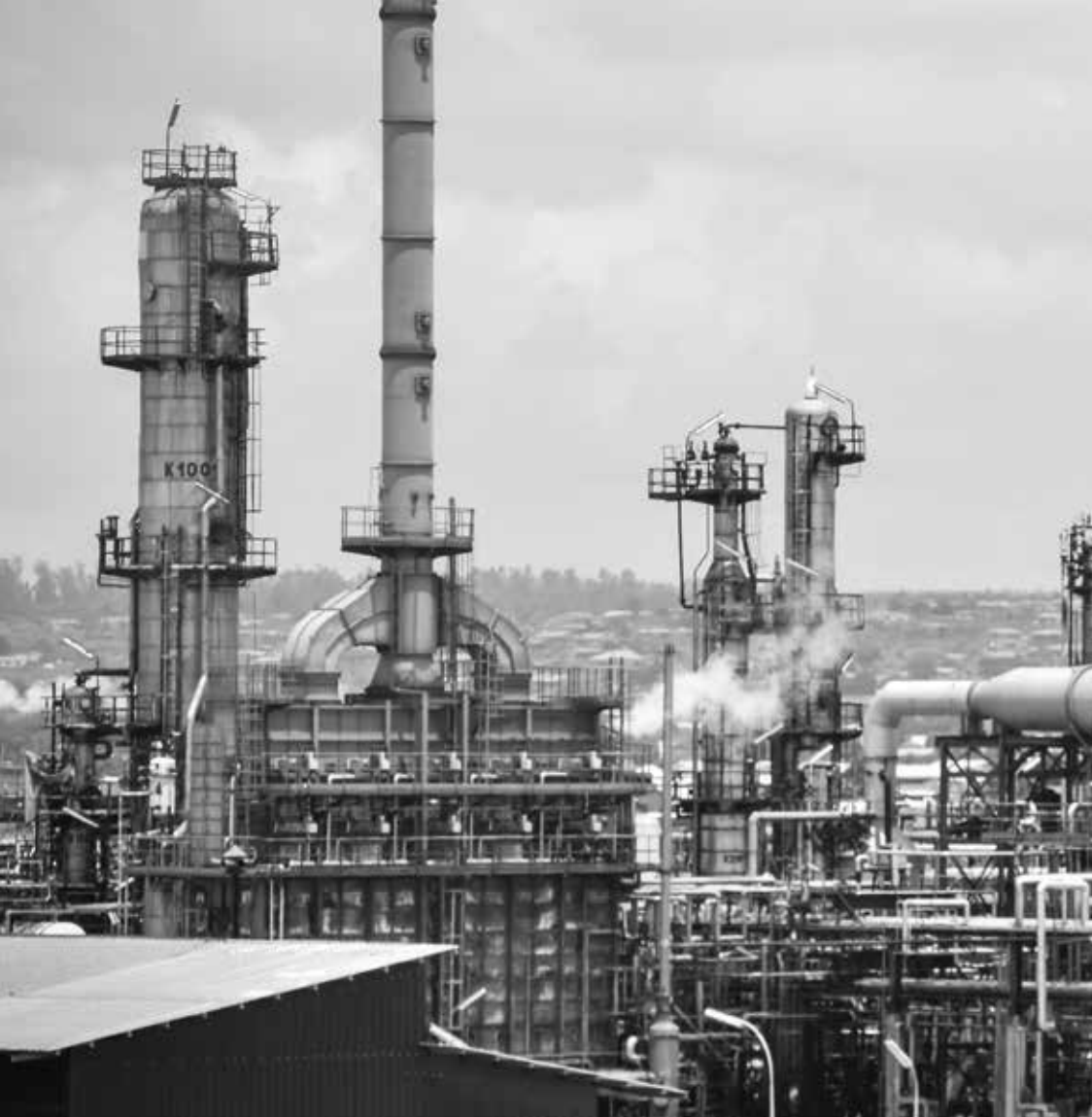
Les installations de raffinage de l'usine CORAF.
