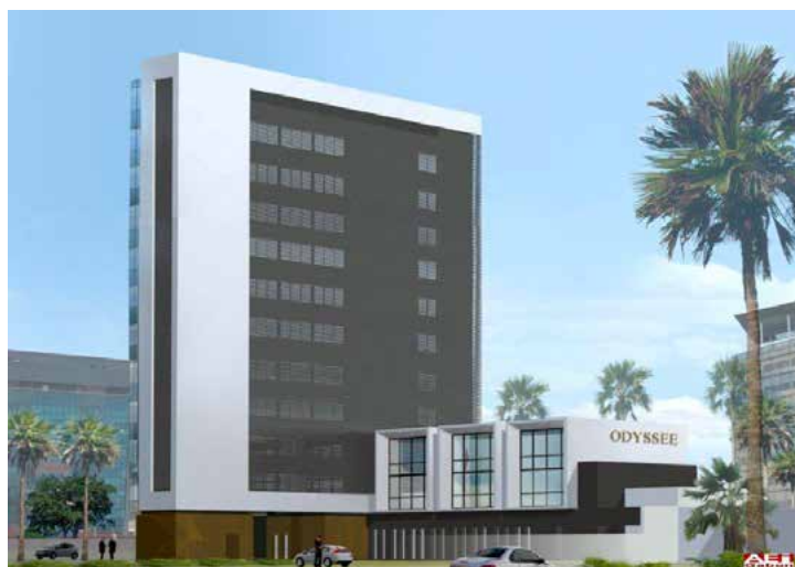
> Le nouvel immeuble d'Assinco en cours d'achèvement
