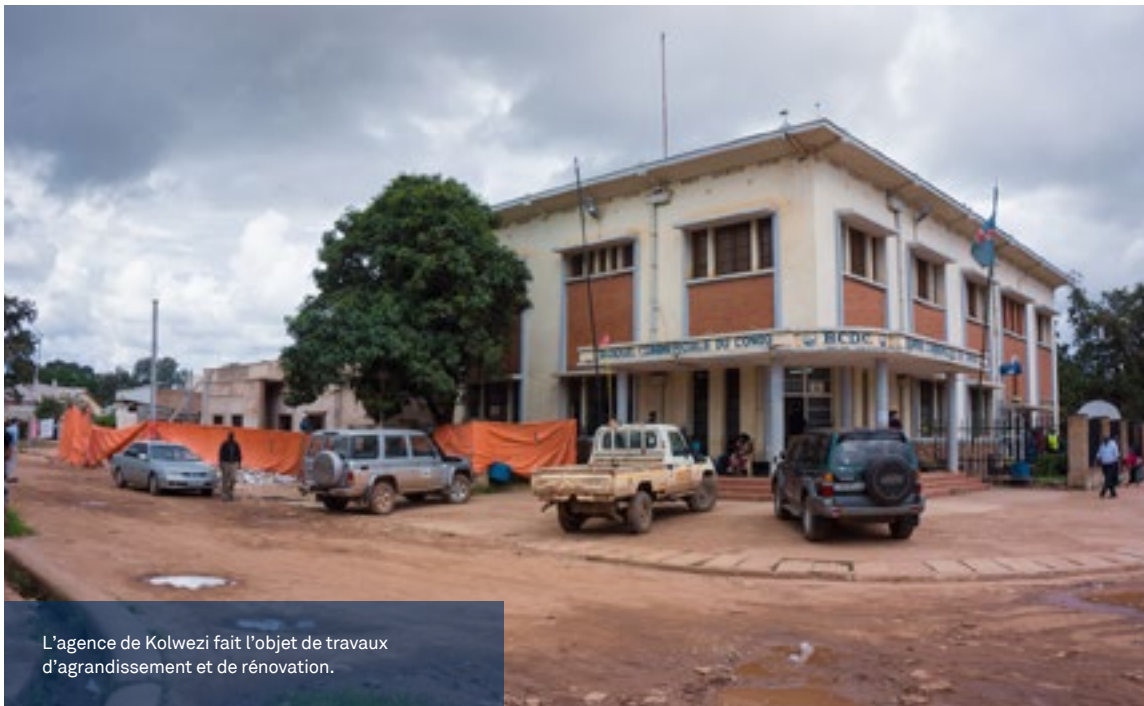
Le bâtiment emblématique de la succursale de Lubumbashi fera l'objet de travaux de rénovation d'envergure. Les travaux débuteront en 2015.
